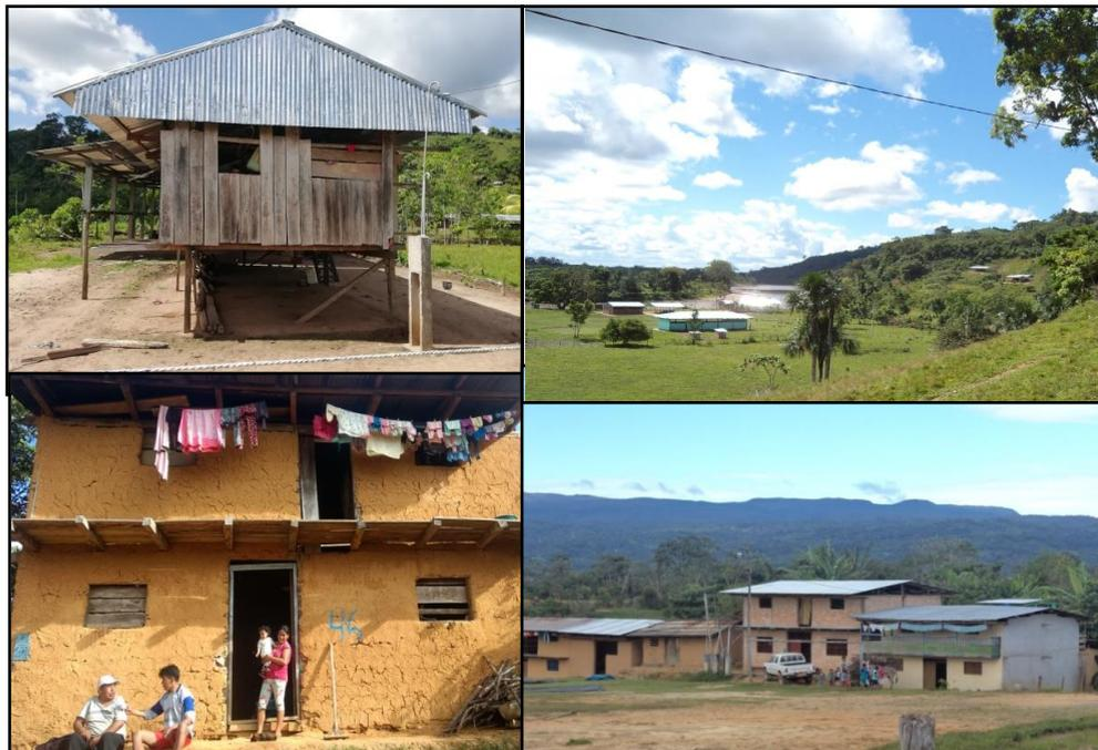
**Fotos 25.** En Balsapuerto las comunidades elevan el piso de sus viviendas, se mudan a la zona alta para soportar la inundación. En Moyobamba, construyen sus viviendas en zonas planas altas y con paredes de ladrillo, quincha, adobe, madera y tapia, y techos de calamina principalmente para protegerse de las lluvias, calor, frío y sismos.
