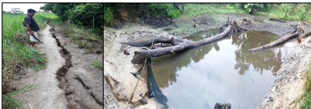
**Fotos 21 y 22.** Grietas en camino producidas por sismo mayo 2019 y piscigranja afectada por rotura de dique, Nuevo Junín, Balsapuerto
