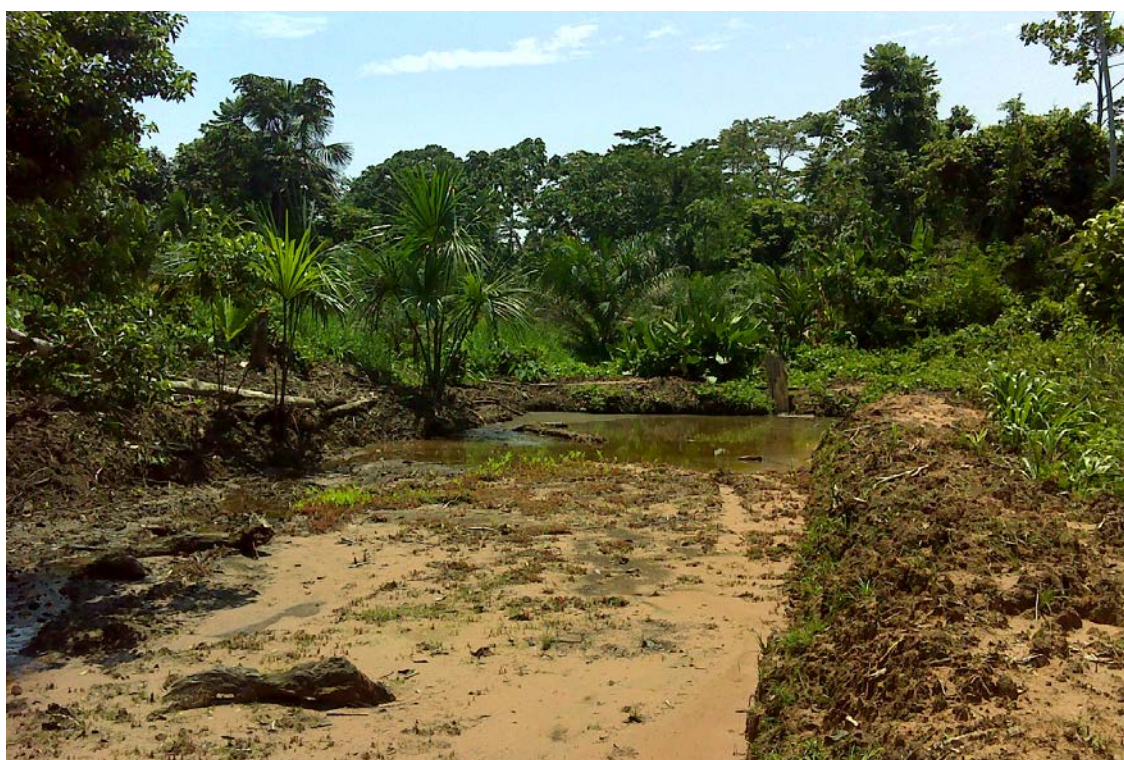
Foto 36. Estanque piscícola en construcción, Caserío Shambillo bajo
