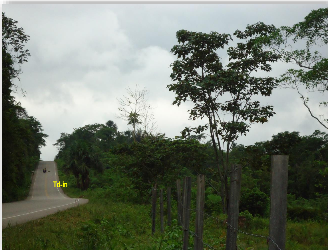
Foto 4. Talud frontal (Td-in), en la carretera hacia la ciudad Aguaytía. UTM: 427,942 E / 8'998,440 N, 412 msnm.
