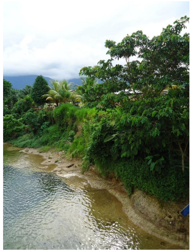
Foto 8. Fuerte erosión lateral a orillas del río Shambo, lateral de CC.NN de Yamino, notar corte de las rocas Terciarias de la formación Ipururo. Tomada desde el puente de acceso a la comunidad. UTM: 429,858 E /9'013,000 N, 290 msnm.
