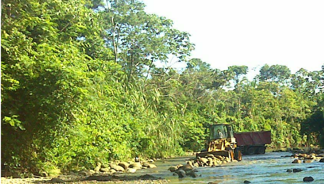
Foto 13. Extracción de “ripió” en el río Shambillo
