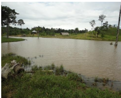
Comunidad La Habana Condición: Operativa
