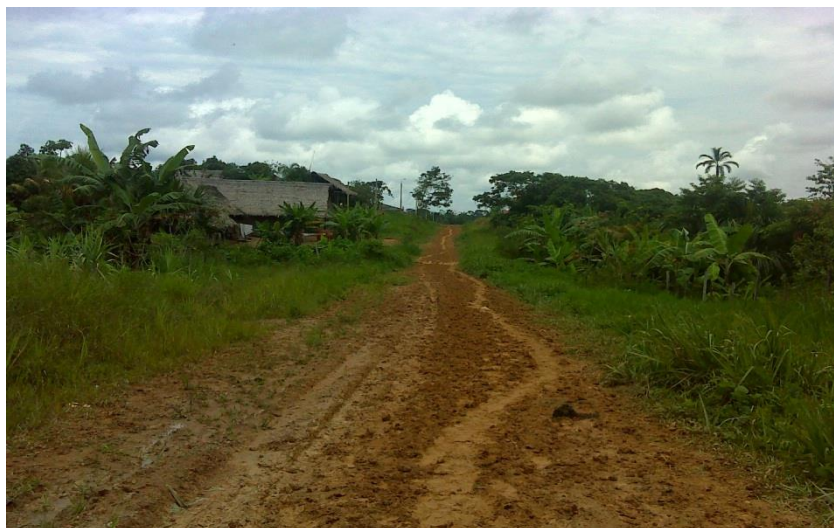
Foto N° 37: Carreteras de penetración a los centros poblados
