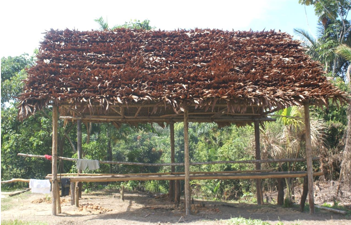
Foto N° 48: Casa en construcción en Villa Belén, en la que usa hojas de “irapay” y “catirina” en el techo; “huacapú” en las esquinas, “pichirina” y “carahuasca” en el cielorraso, entre otras especies.
