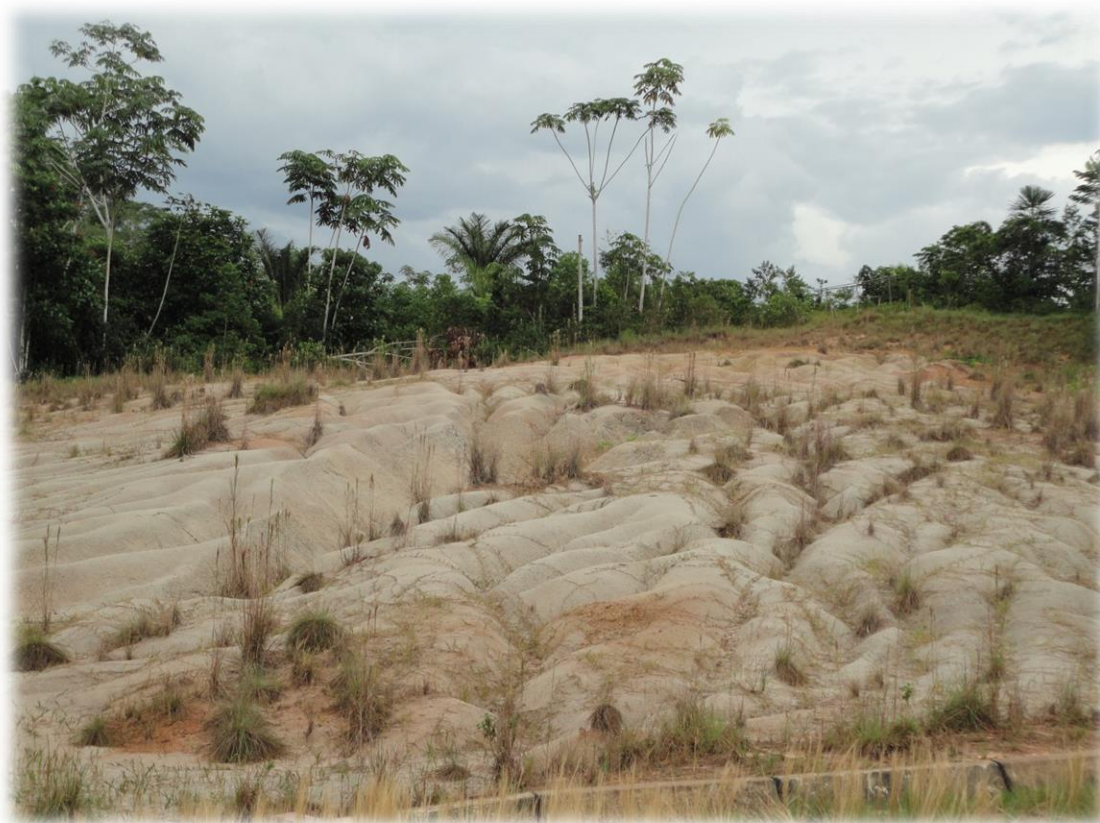
Foto N° 19: Densa red de surcos y cárcavas entre los caseríos de San Juan y 1ro de Febrero. La deforestación y la presencia de rocas terciarias deleznable, han activado el proceso
