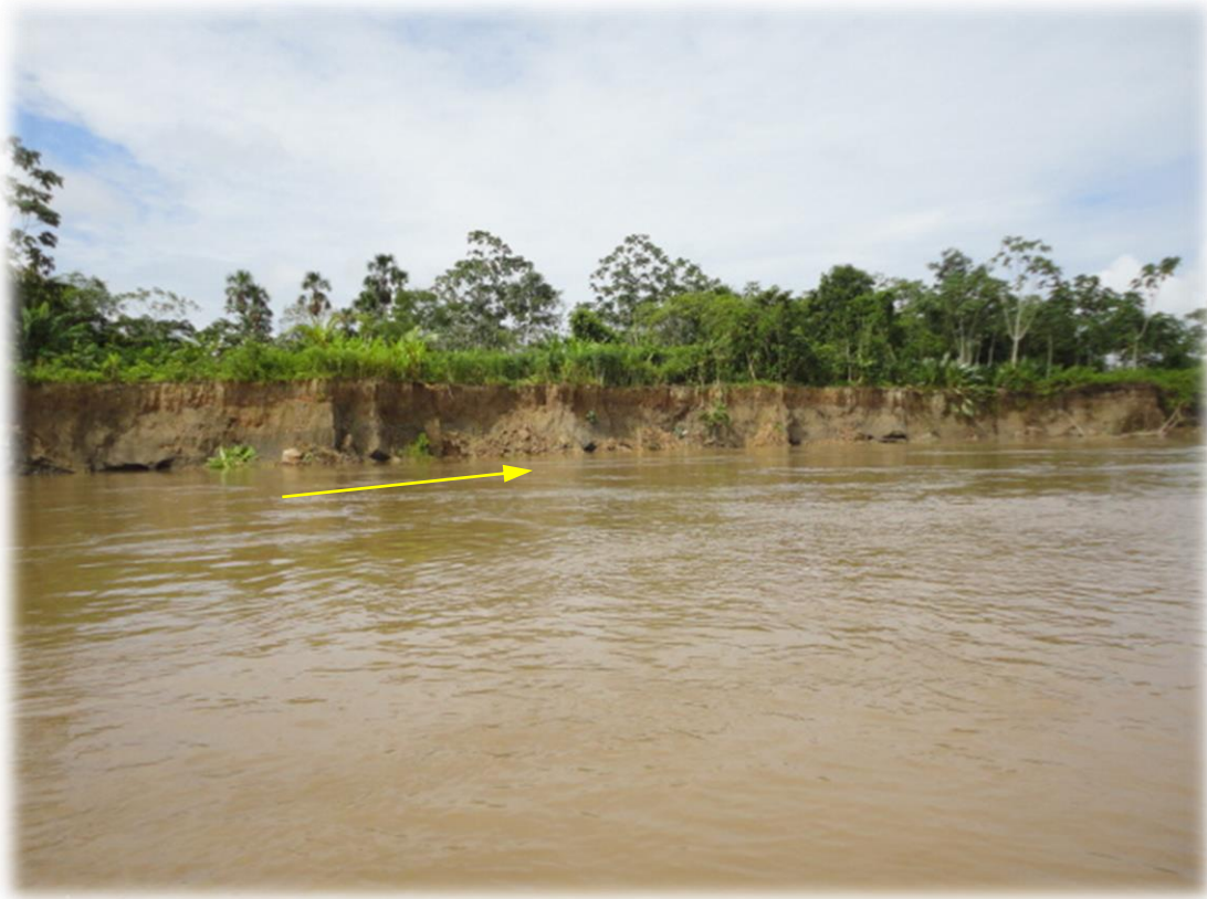
Foto N° 17: Sector de fuerte erosión lateral, con existencia de rocas terciarias deleznales, generada por el río Amazonas;(UTM: 696.104 E / 9'562,330 N, cota de 87 msnm).
