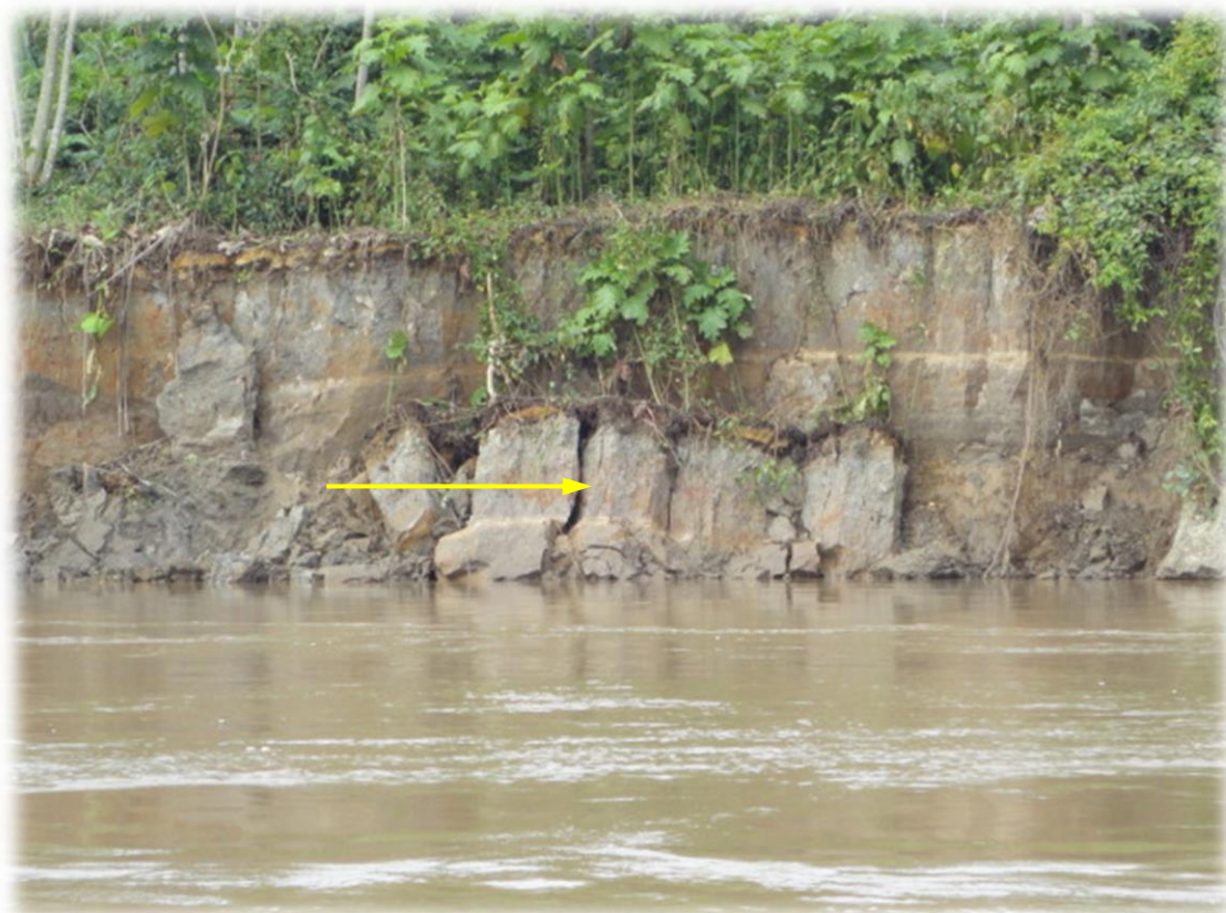
Foto N° 22: Derrumbe de paquetes de limoarcillitas terciarias, en la margen izquierda del río Amazonas, originado por socavamiento fluvial. (UTM: 691,742 E / 9'564,374 N, cota de 84 msnm).
