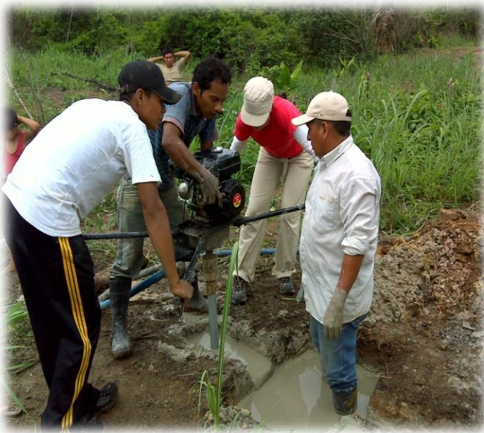
Foto N° 35: Napa freática (reservorio de agua) ubicada en el centro poblado El Porvenir (perforación).
