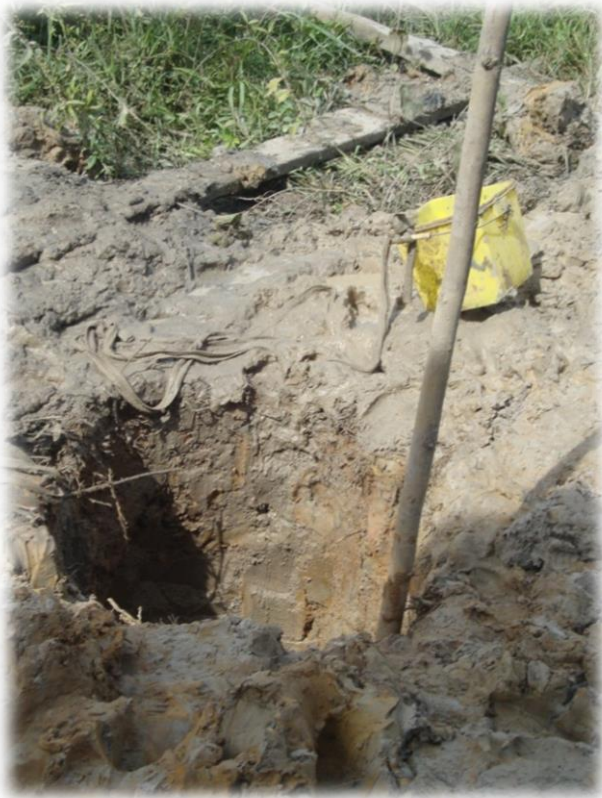
Foto N° 36: Napa freática (reservorio de agua) ubicada en la carretera el Paujil II Zona km 35.5.
