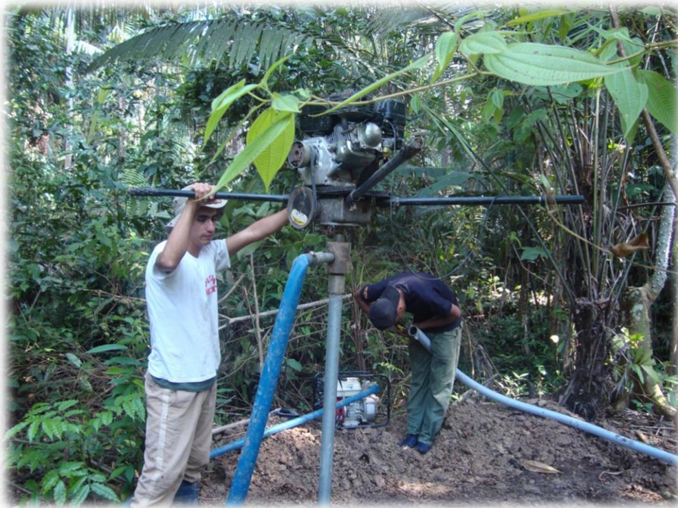
Foto N° 01: Perforación de un pozo para extraer muestras sedimentarias en el centro poblado Terra Bona (margen izquierda río Amazonas).
