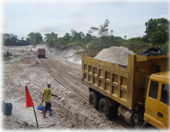
Foto N° 25: Cantera de propiedad de la señora Sheyla Rubiños Bartens, en el eje de la carretera Iquitos - Nauta Km 25.
