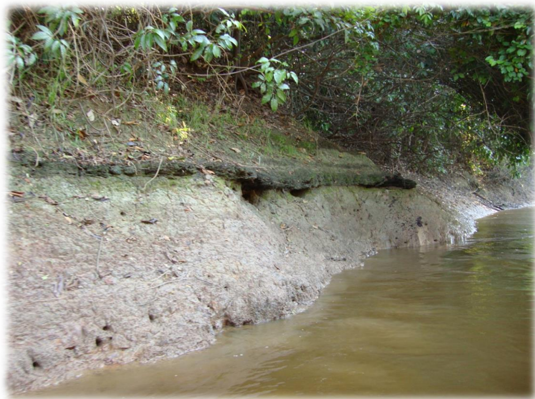
Foto 6: Niveles de arcillita gris y arcilla moteada, con intercalaciones de materia orgánica. Sector río Aypena.
