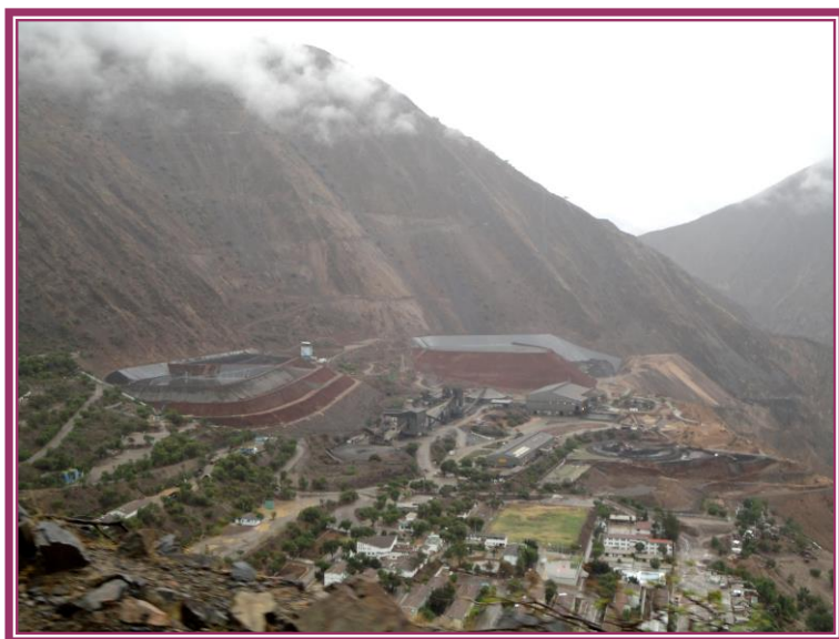
Foto 35. Mina Cobriza, centro de almacenamiento y procesamiento del mineral de cobre (relaves). Centro poblado Expansión-provincia de Tayacaja. Octubre 2010.
