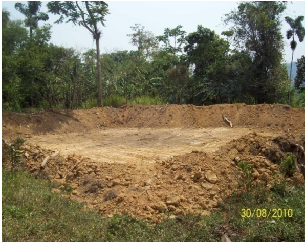
Figura 7. Estanque en construcción
