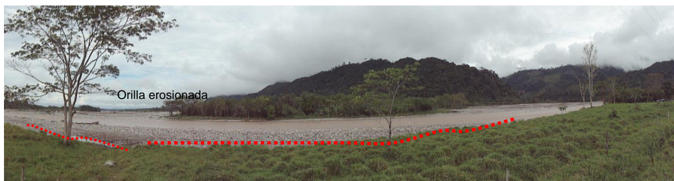
Figura 24. Erosión lateral del río Pozuzo. Localidad Codo del Pozuzo. Julio 2010
