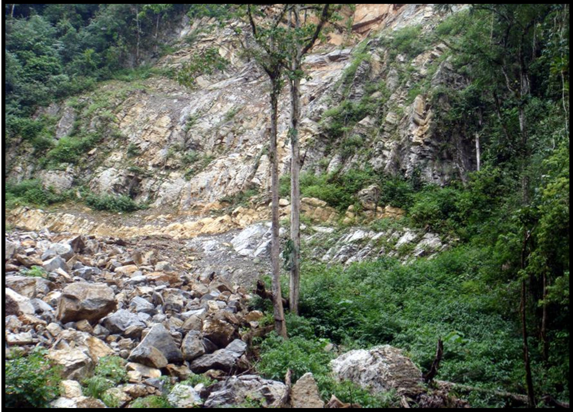
Foto 9. Caída de bloques actual.
