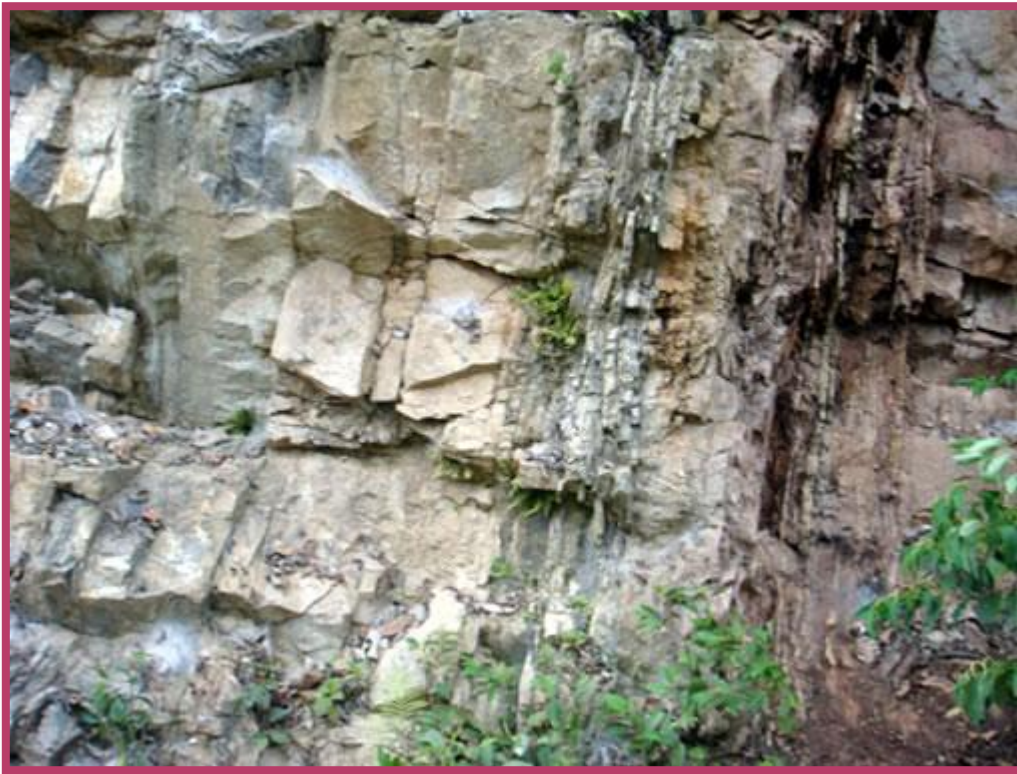
Foto 12. Secuencias de areniscas competentes en estratos delgados intercalados con niveles delgados de lodolitas y niveles laminares de calcita, correspondientes a la Formación Yahuarango. Localidad de Boca Satipo. Octubre 2008.
