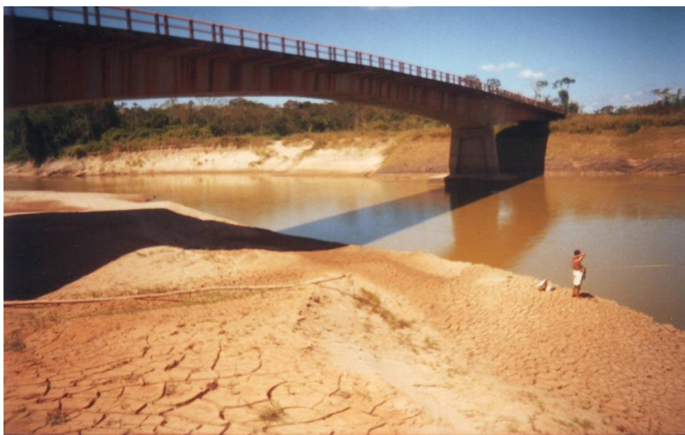
Foto 01. Vista del río Tahuamanu en el cruce del Puente Tahuamanu
