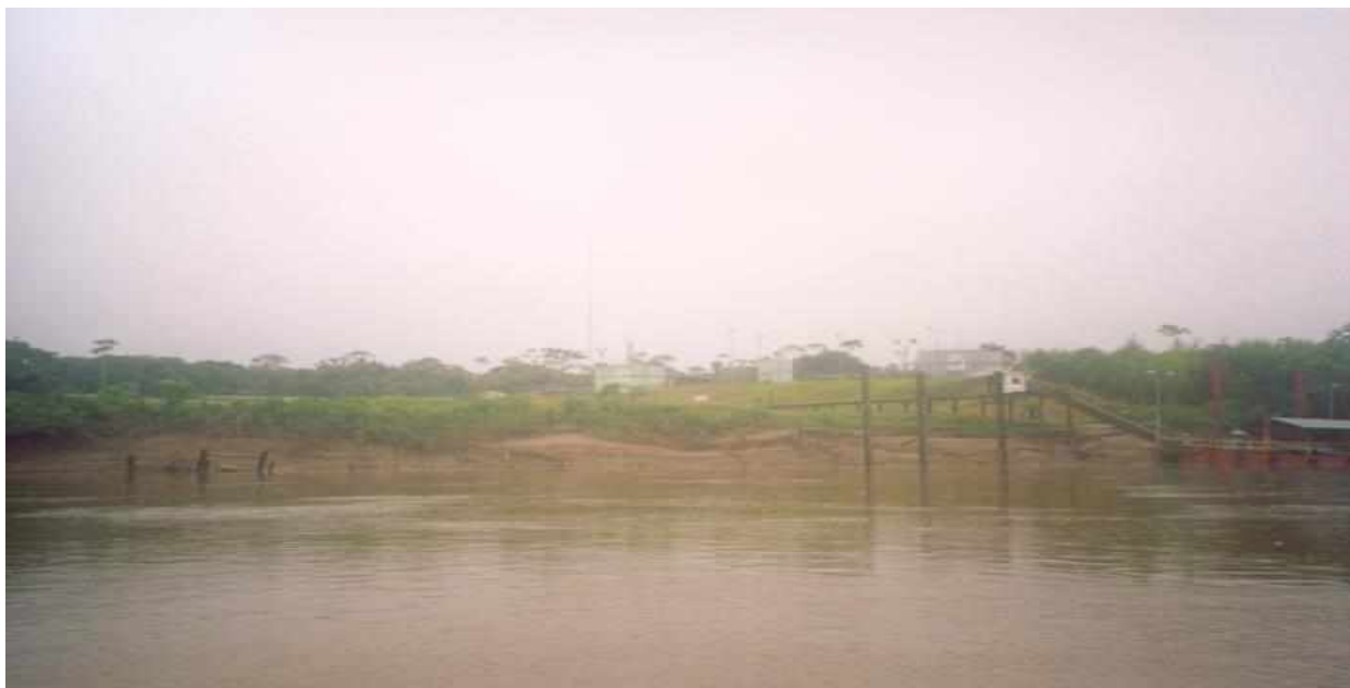
Infraestructura de la industria petrolera emplazada en laderas erosionadas de la planicie aluvial existentes en la zona, geformas suaves que dominan el paisaje local. Estación de Bombeo Fernando Rosas, margen derecha del río Morona. Mayo, 2006
