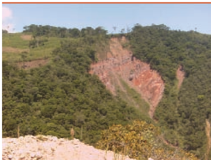
Foto 25. Zona con problemas de erosión y derrumbes.
