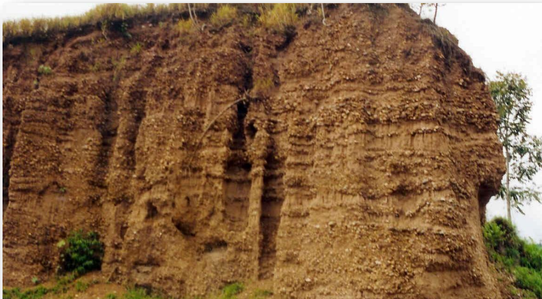
Foto N° 30. Secuencias de niveles conglomerádicos, que se exponen en forma masiva. Tramo Saposoa-Sacanche, año 2003.WC.
